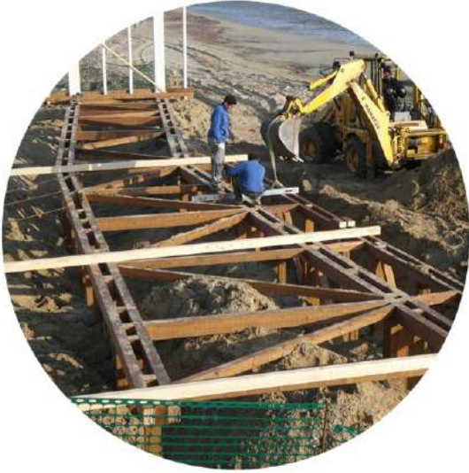
1. Sottostruttura a traliccio in legno
