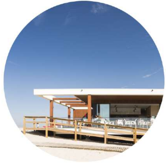
2. Rampa di accesso
