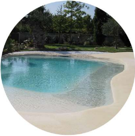
1. Piscina a conformazione naturale con sponde a pendenza contenuta, profondità massima 1.2 m
