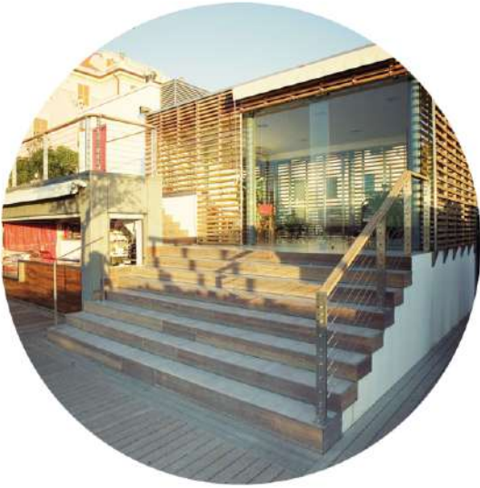
1. Scala di accesso
