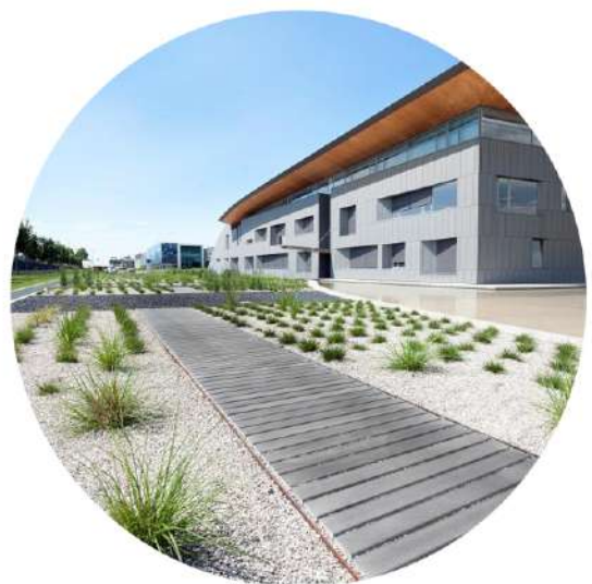
6. Pavimento a doghe decking in quarzo e marmo
