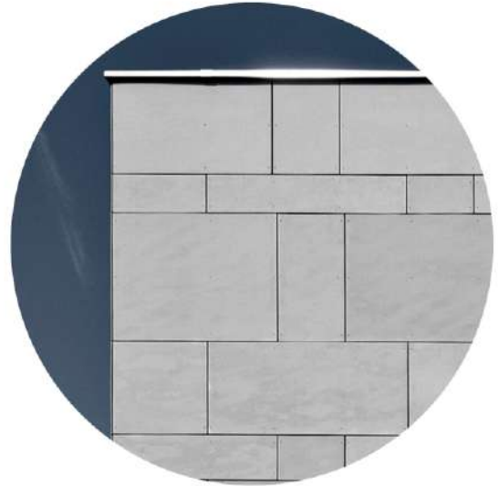
2. Rivestimento a quadrotti di fibrocemento
