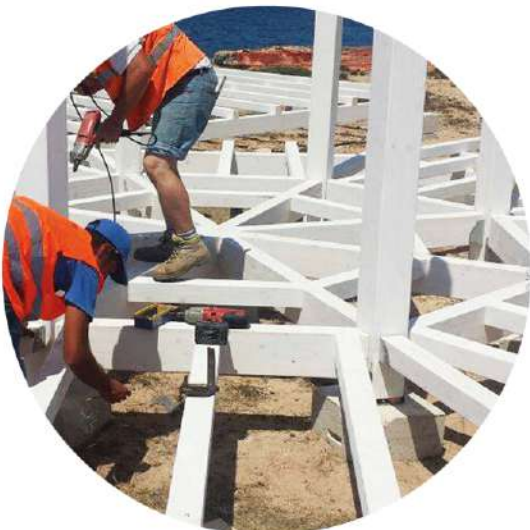
5. Sottostruttura in legno su plinti in c.a.
